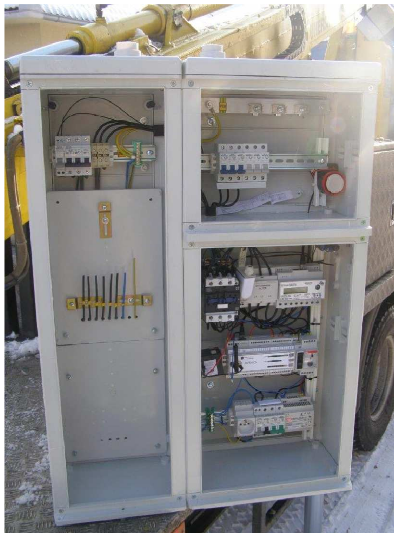
po realizácii projektu
