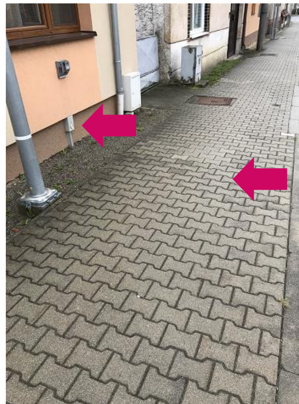
rok od realizácie v spevnej ploche spätne uloženie dlažby
