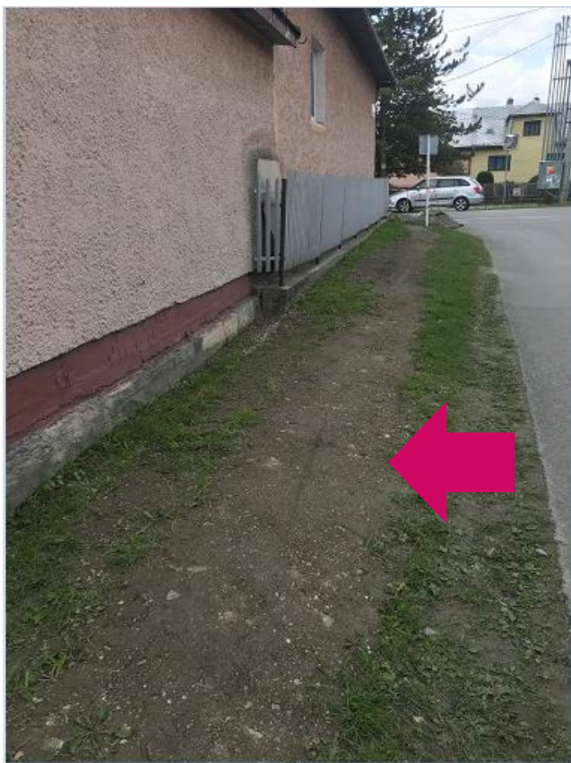
prebiehajúca realizácia v zelenom páse – úprava výkopu po
