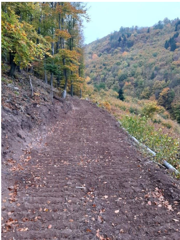
Obnovená zväžnica v Kaláni
