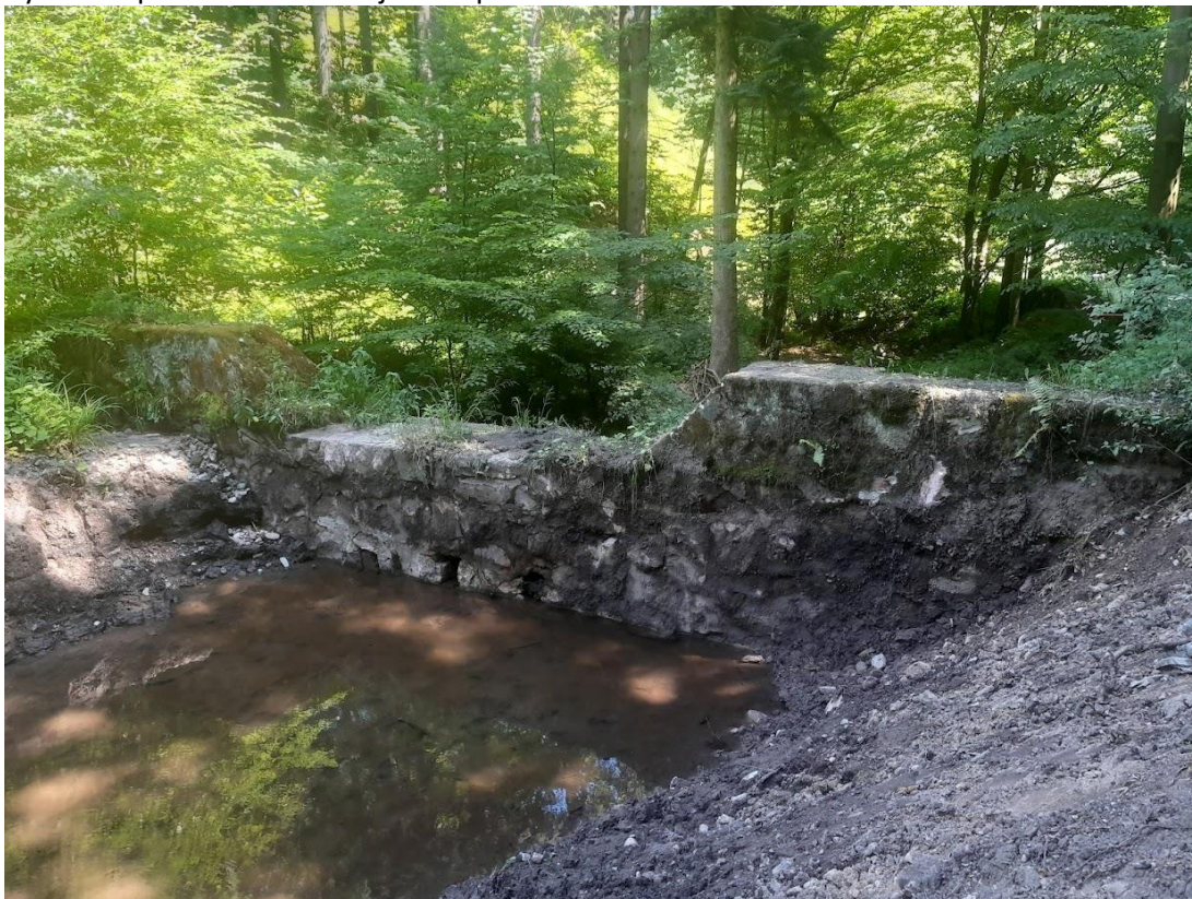
Vyčištěná prehrádzka nad hájenkou pod Starou Hutou
